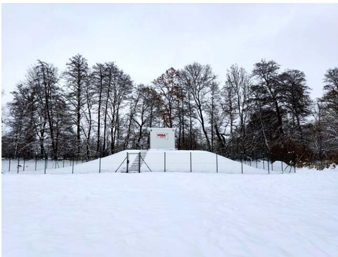
Úpravna vody na Velké Ledské
