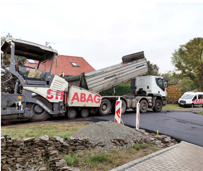
Foto z realizace na Pasekách
