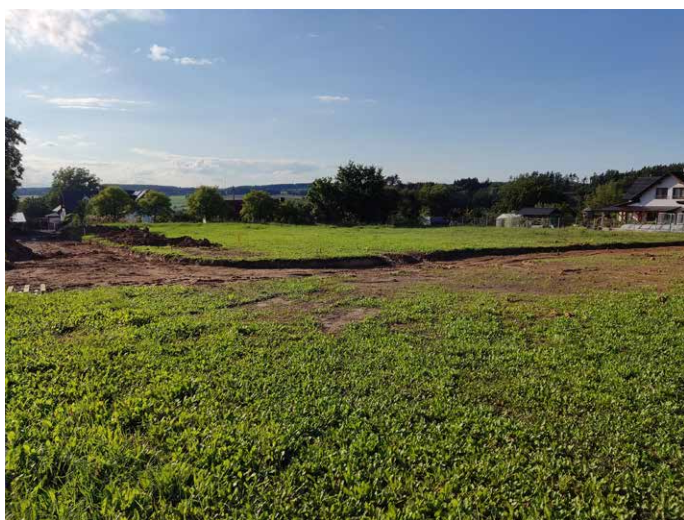
Z průběhu realizace – nové stavební parcely v lokalitě „Nad Podlískou“.
