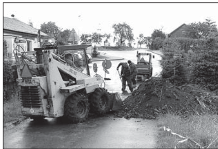
Terénní práce při opravě
