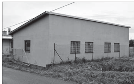
Výstavba skladu u palírny Libotovský byla také podpořena dotací z MAS Hřibiny
